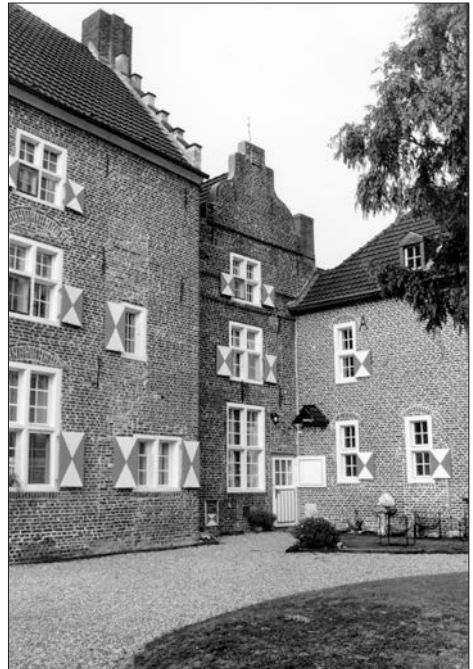
Haus Steprath heute. Der mittlere Teil der Gebäude stammt wohl noch aus der Zeit von Godert und Katharina von Hüls
