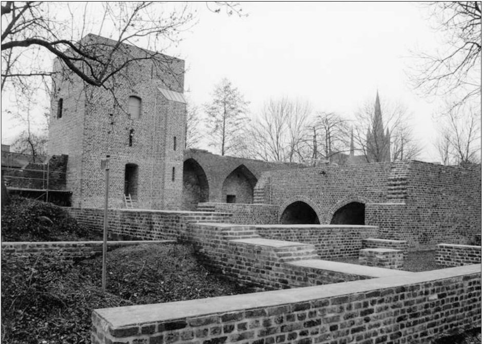
Hülsener Burgruine – Stand der Sanierungsarbeiten Februar 2004
